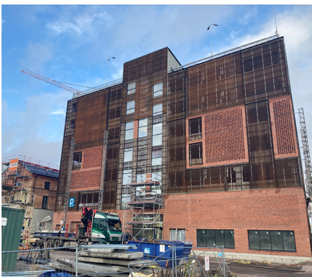
Bild från byggnationen av Pralinen november - 2022
